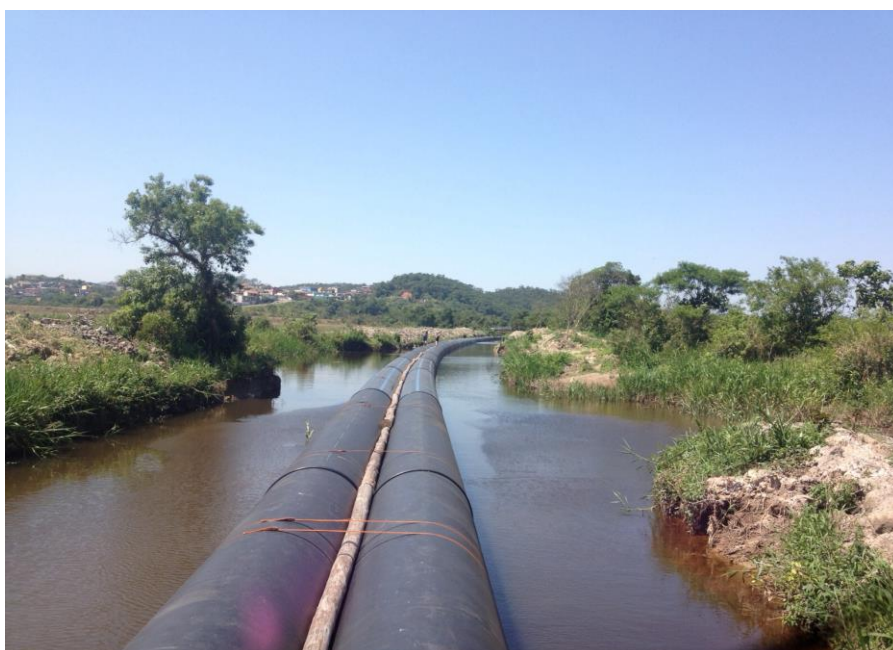
Figura 8 - Foto das tubulações que transportam água do Sistema Rio Grande para o Rio Taiaçupeba Mirim
